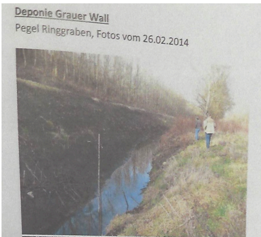
Abb. 2: Ringgraben, wie er von der Gewerbeaufsicht im Jahr 2014 dokumentiert wurde: Es handelt sich um einen einfachen, mit Gras bewachsenen Graben ohne jegliches Rückhaltevermögen für Schadstoffe. Der Ringgraben steht in Verbindung mit der Neuen Aue, die über das Grundwasser Verbindung zum Bootsteich im Speckenbütteler Gesundheitspark hat. Die "Grundwasser- und Geotechnische Planungskarte Bremerhaven" des Niedersächsischen Landesamtes für Bodenforschung bestätigt dies auf S. 54: "Die Neue Aue hat hier am Übergang Marsch zu Geest vermutlich direkten Kontakt zum Grundwasserleiter".
